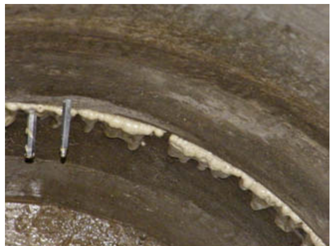
Abb. 3: Applikation im Großversuchsstand: Abdichtung mittels Stopfmörtel, Eindrücken des Reparaturmörtels von Hand in eine Schachtringfuge (oben links) und von Stopfmörtel in eine Schadstelle (oben rechts); Abdichtung mittels Injektion, Bohren eines Packerlochs (unten links) und ausgetretenes Polyurethanharz aus der verdämmten Schachtringfuge (unten rechts)
