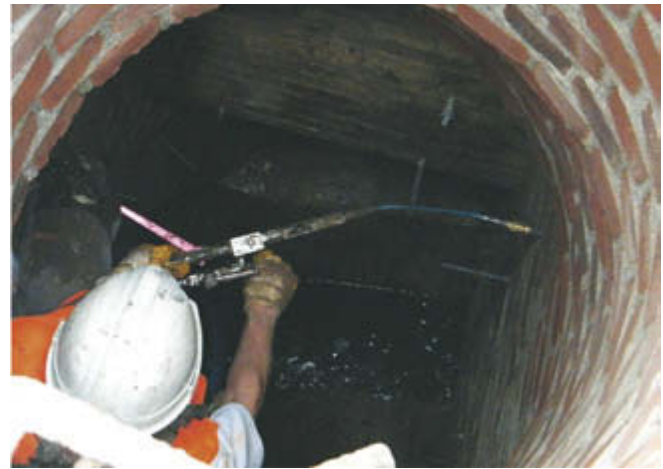
Abb. 1: Eindruck aus In-situ-Maßnahmen: Abdichtung der Rohranbindung, gesetzte Packer (oben, links) und Sanierungsergebnis (oben, rechts); Abdichtung des Schachtkörpers, Einsatz von Stopfmörtel (unten, links) Injektion (unten, rechts)
