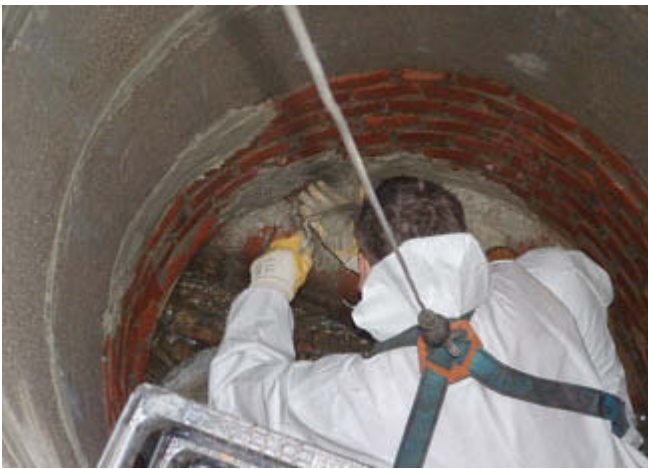
Abb. 1: Eindruck aus In-situ-Maßnahmen: Abdichtung der Rohranbindung, gesetzte Packer (oben, links) und Sanierungsergebnis (oben, rechts); Abdichtung des Schachtkörpers, Einsatz von Stopfmörtel (unten, links) Injektion (unten, rechts)
