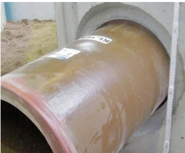
Abb. 6: Aufbau der Großversuche, Detailansicht der Rohreinbindungen: kleine Ringräume bei DN 150 (oben) und größere, abgestufte Ringräume bei DN 300 (unten)
