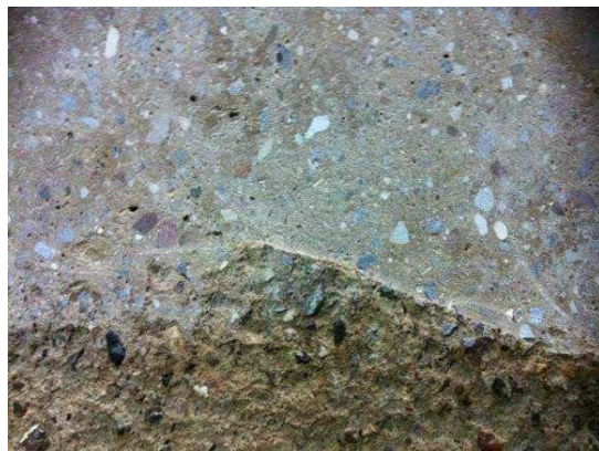
Boden geschliffen und original (sehr Rau, Wasseraufnahme 500g/m 2 )
