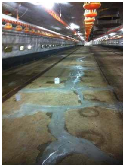
Links: Nach Rissverfüllung
