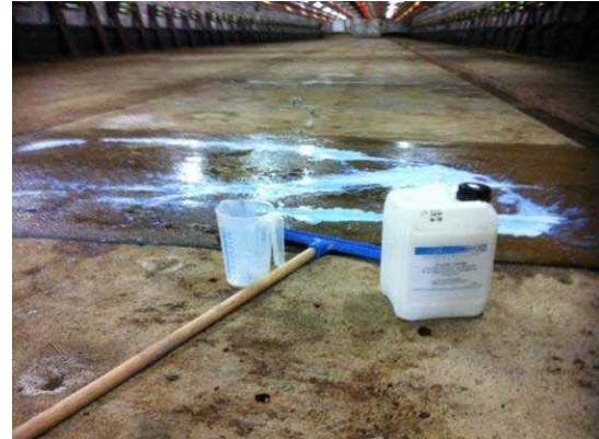
Rechts: Applikation Sinnofloor Coating
