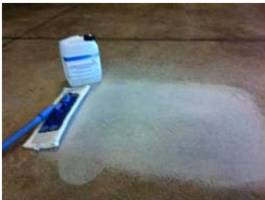
Fläche geschliffen, Applikation Sinnofloor
